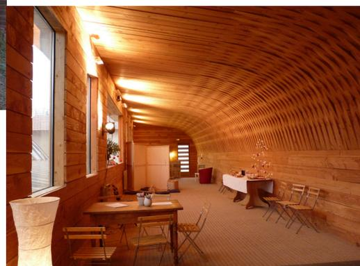
Le Patadôme est une **construction en demi-sphère de bois naturel** recouverte de zinc, encastrée aux 3/4 dans un bâtiment carré également en bois.
